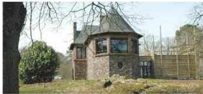
Pour créer l'Aparté, Montfort Communauté a consacré 400 000 € à la rénovation du manoir de Trémelin.
